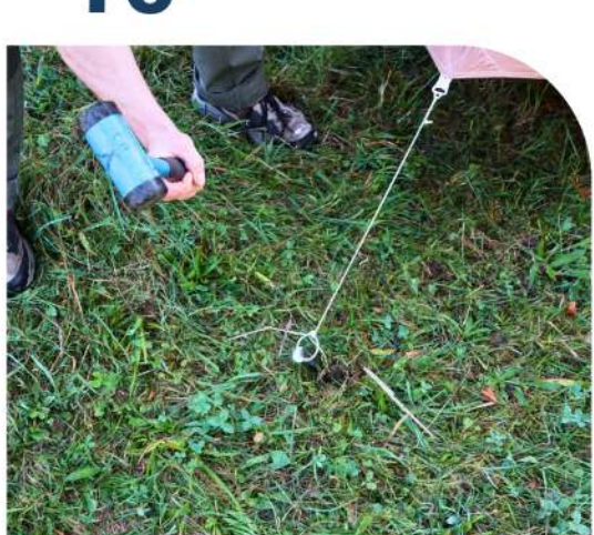
Spannschnüre möglichst lang lassen und Heringe mit Gummihammer einschlagen
